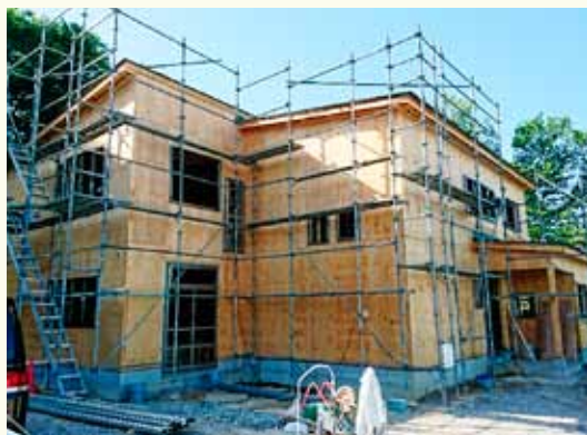
5月末時の建設途中の建物です
