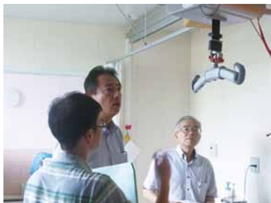
入浴介助用設備
